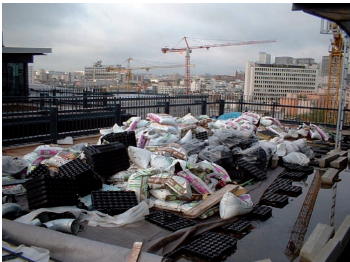
Der Grund von Undichtigkeiten liegt oft in Beschädigungen während der Bauzeit.
